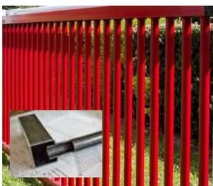
**Structure à barreaudage** : assemblage renforcé anti-vandalisme par insertion des barreaux dans les lisses avant soudure
