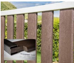
**Cadres en lames composites recyclées et recyclables** : assemblage vertical des lames dans le bâti conférant une grande robustesse à l'ensemble
